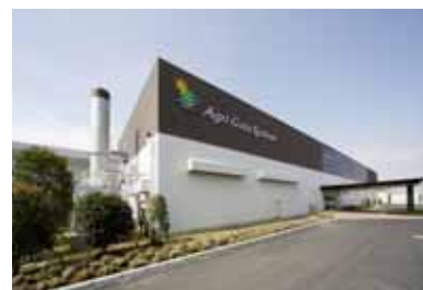
アグリガイアシステム 循環型飼料化センター外観
