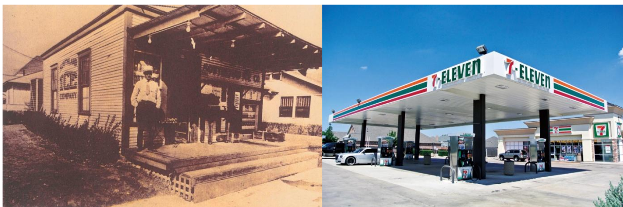
写真左：世界初のコンビニエンスストアとなった「サウスランド・アイスカンパニー店舗」
