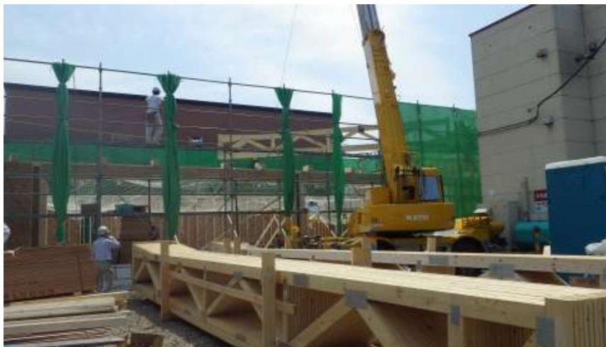
セブン-イレブン美唄大通南店（建築時の様子）
