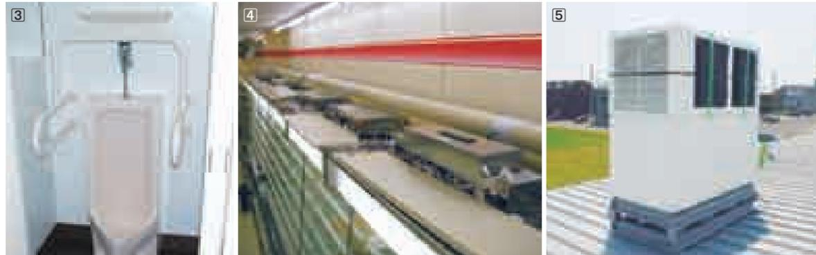
店舗にはベリアフリートイレを設置しています 渋川御幸田店では、ノンフロン型の冷却システムを導入しています(④)チルドケース上部に冷媒の配管を設置 ⑤冷凍機を屋上に設置
